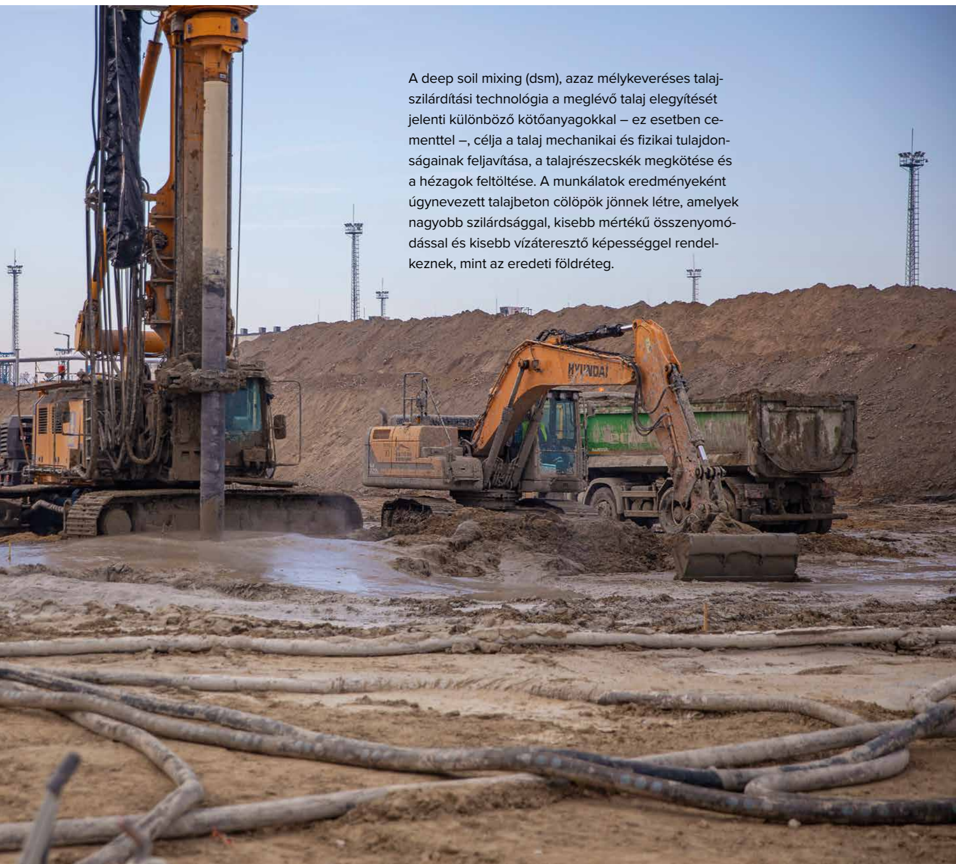
A talajszilárdítást a Bauer BG 45 típusú, 433 kW teljesítményű munkagépei végzik.
