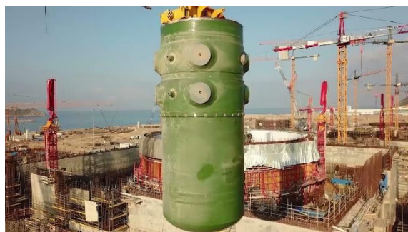
1. ábra: Az Akkuyu török atomerőmű VVER-1200 reaktortartályának helyére emelése
